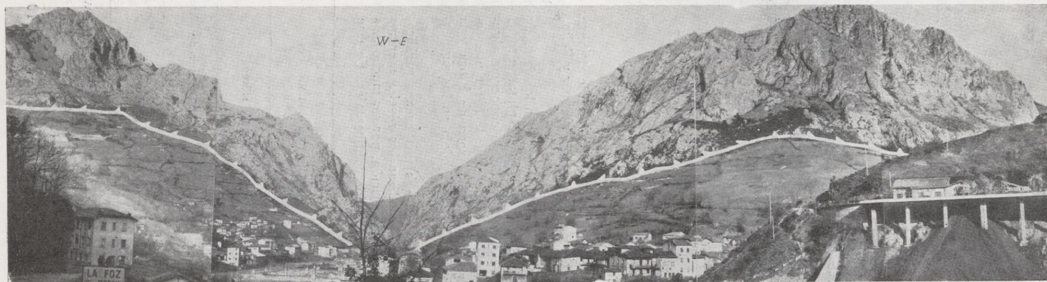
Fig. VI.—Panorámica del frente de cabalgamiento en el valle de La Foz de Morcín. En primer plano, a derecha e izquierda del valle, aparece el conglomerado silíceo Westfaliense D Inf.
